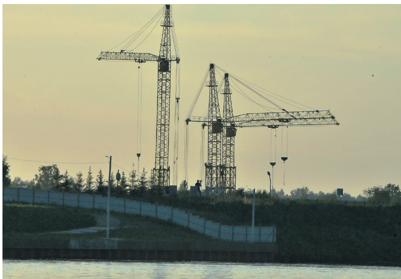
Стройка на месте братских могил. Правый берег Невского пятачка
